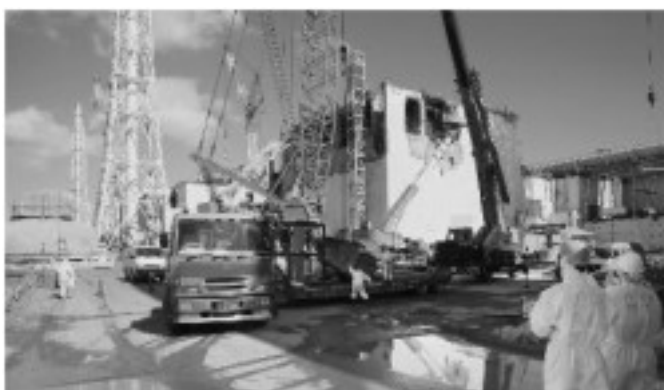
がれき除去作業 福島第1原発の4号機原子炉建屋
